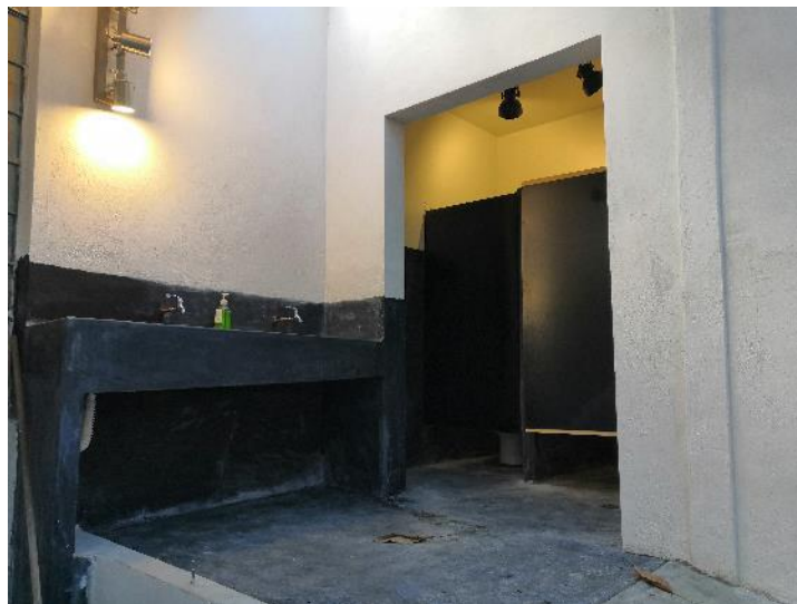
Remodelación de los sanitarios, dic. 2020
